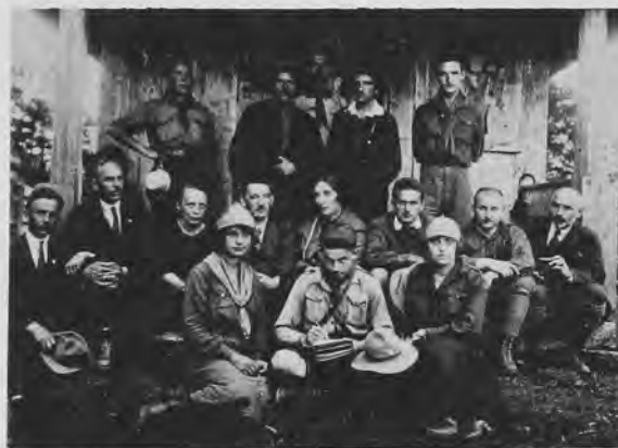
Перед будинком таборового проводу на Соколі.
