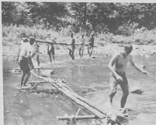
Отже, будують міст! Справжній піонерський, на козлах, без жадного цвяха.
